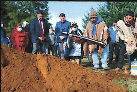
40021191-0 AMPLIACION SISTEMA AGUA POTABLE SAN RAMON, A COLLIMALU, PENCHUCON Y RIGUEN, LONCOCHE MS 1.267.588 FECHA DE INICIO: 15/01/2022
