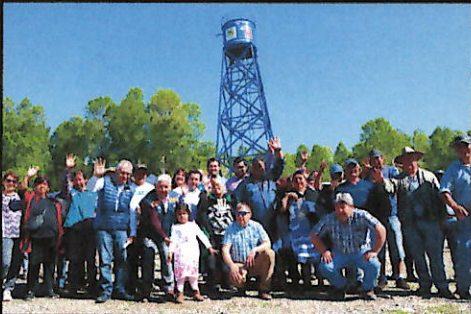
20187195 INSTALACIÓN SISTEMA AGUA POTABLE BULCAHU, CUNCO MS 868.922
